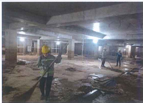
Công tác dọn dẹp vệ sinh tầng hầm
