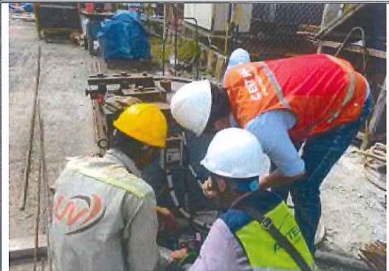
Đo kiểm tra máy móc thiết bị điện
