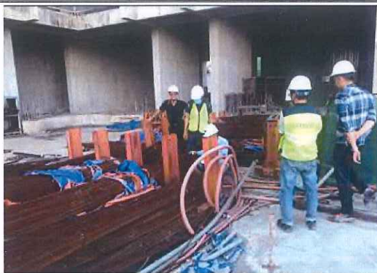
Công tác lấy mẫu thép hiện trường kiểm tra chất lượng cốt thép hiện trường
