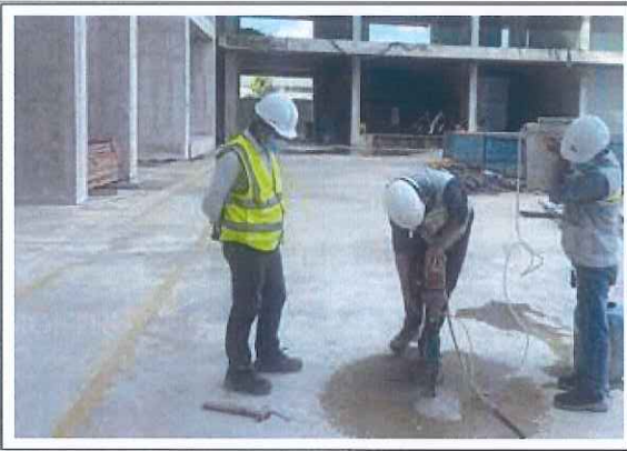
Công tác khoan lõi kiểm tra chất lượng bê tông hiện trường
