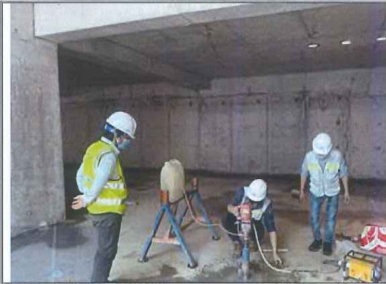
Công tác khoan lõi kiểm tra chất lượng bê tông hiện trường
