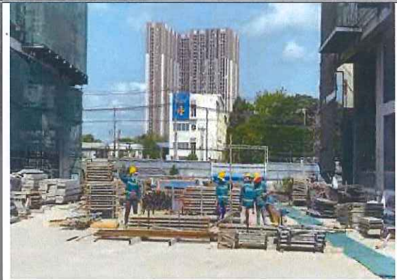
Công tác sắp xếp vật tư thiết bị thi công
