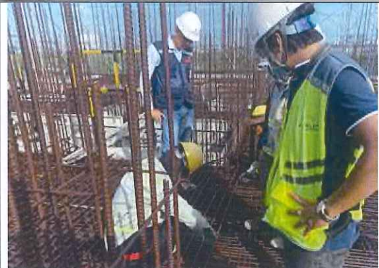
Công tác lấy mẫu thép hiện trường kiểm tra chất lượng cốt thép hiện trường
