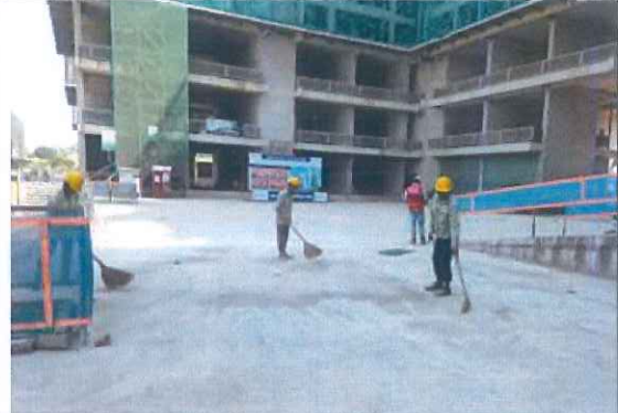
Dọn dẹp vệ sinh mặt bằng công trình
